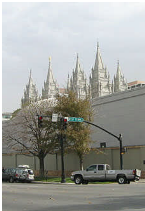
Hinter den Mauern erhebt sich der Temple
